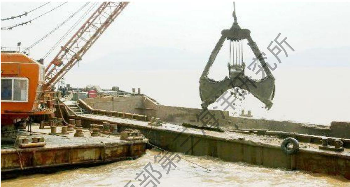
图 2.4-1 挖泥船挖泥装驳
