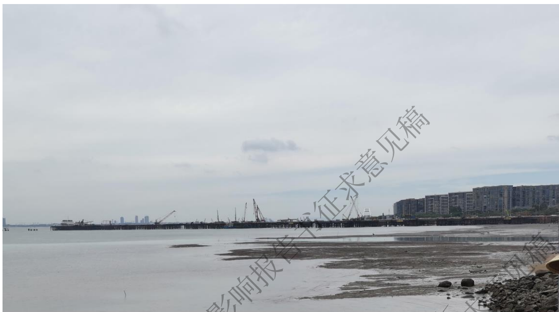
图 4.4-6 正在施工的第二东通道栈施工栈桥
