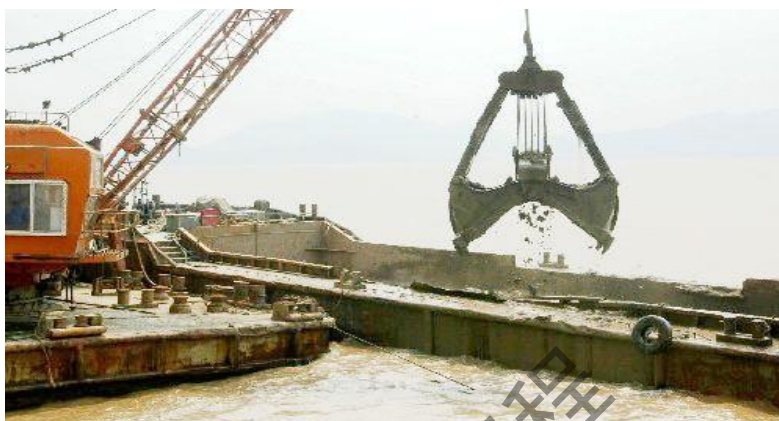
图 2.2-3 挖泥船挖泥装驳示意图
